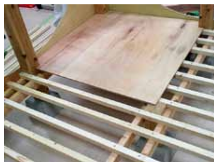
床工事。束・大引・根太・床板が見える。
