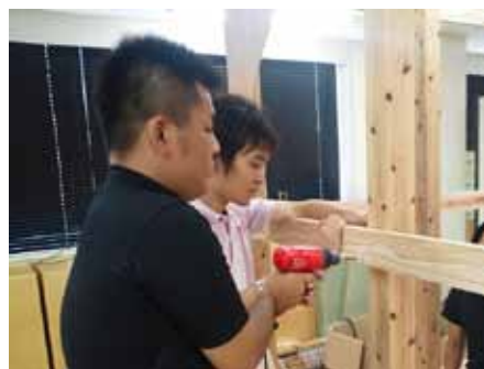
面接合。施工時間短縮と施工難度の軽減。
